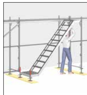
Fig. 74: Montering av Repotrapp
