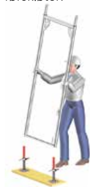
Fig. 29 Montering på fotspindler
