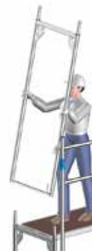
Fig. 30 Montering på rørskjøt, sikre med Låsepinne
